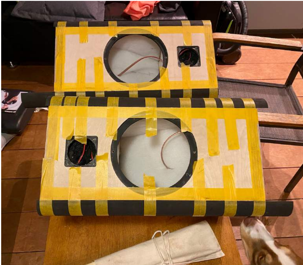
Figuur 28: Het lijmen van de zwarte ronde stroken, de delen die uitsteken worden na drogen lijm afgezaagd met Japanse zaag.
