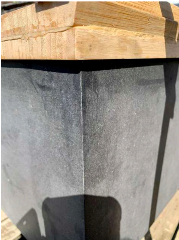
Figuur 66 Detail opname van buiten naad, de 45 graden verstek naad sluit perfect.
