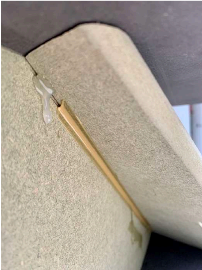
Figuur 39 Nog een detail van aangebrachte lijm met lijmpistool bovenin. Nadat woodmax voldoende uitgehard is kan lijm van lijmpistool weggesneden worden en naad eventueel afgestreaken met woodmax
