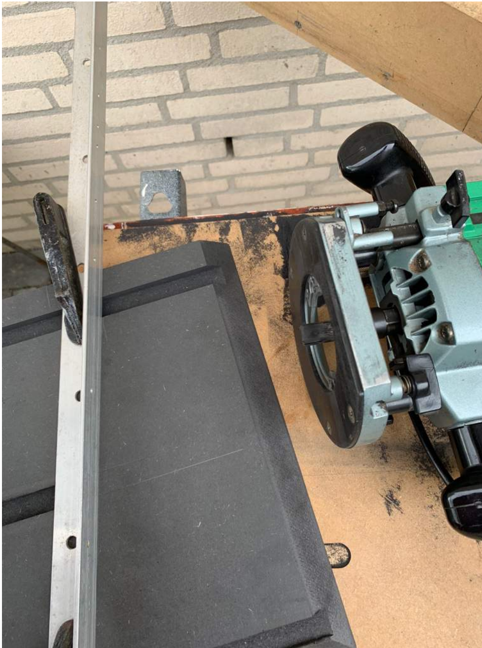
Figuur 14 Het frezen van de andere schuine sleuf
