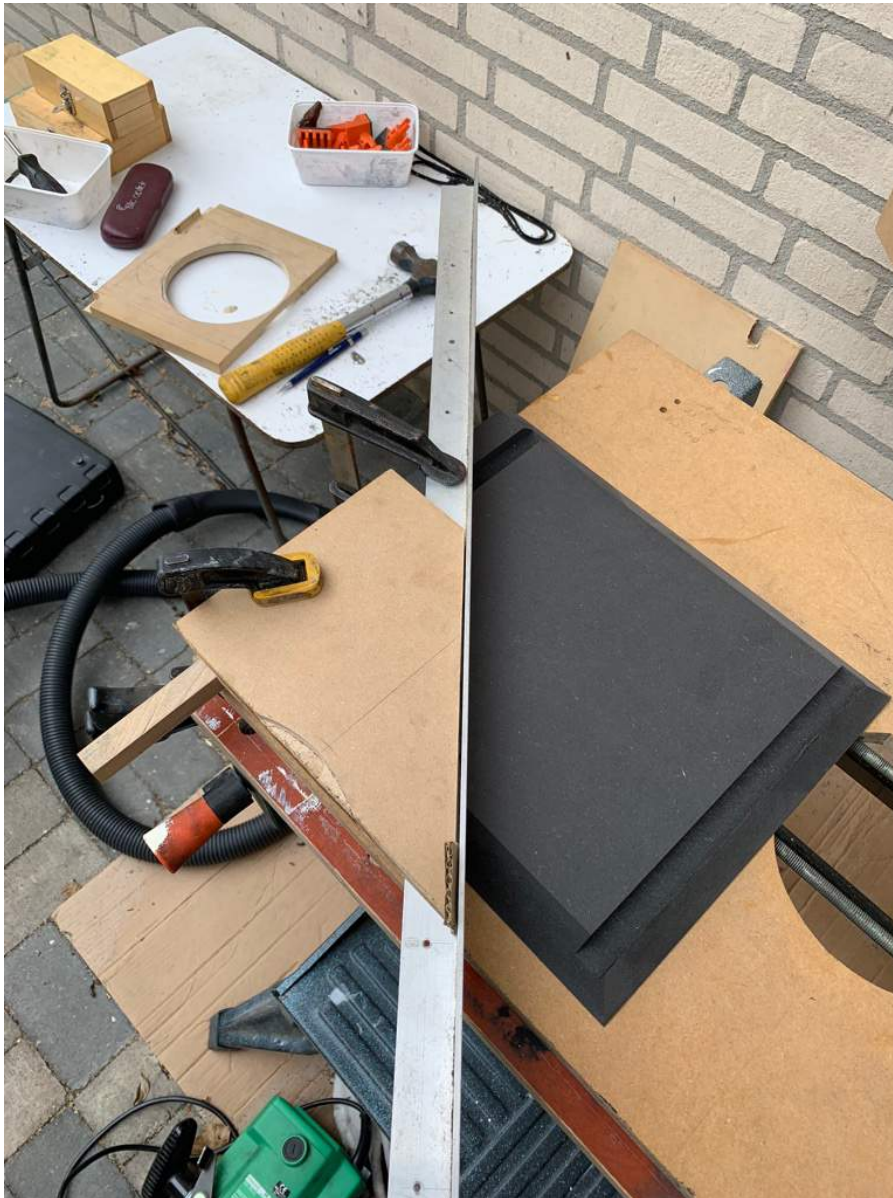
Figuur 13 Frezen van sleuf onder 45 graden
