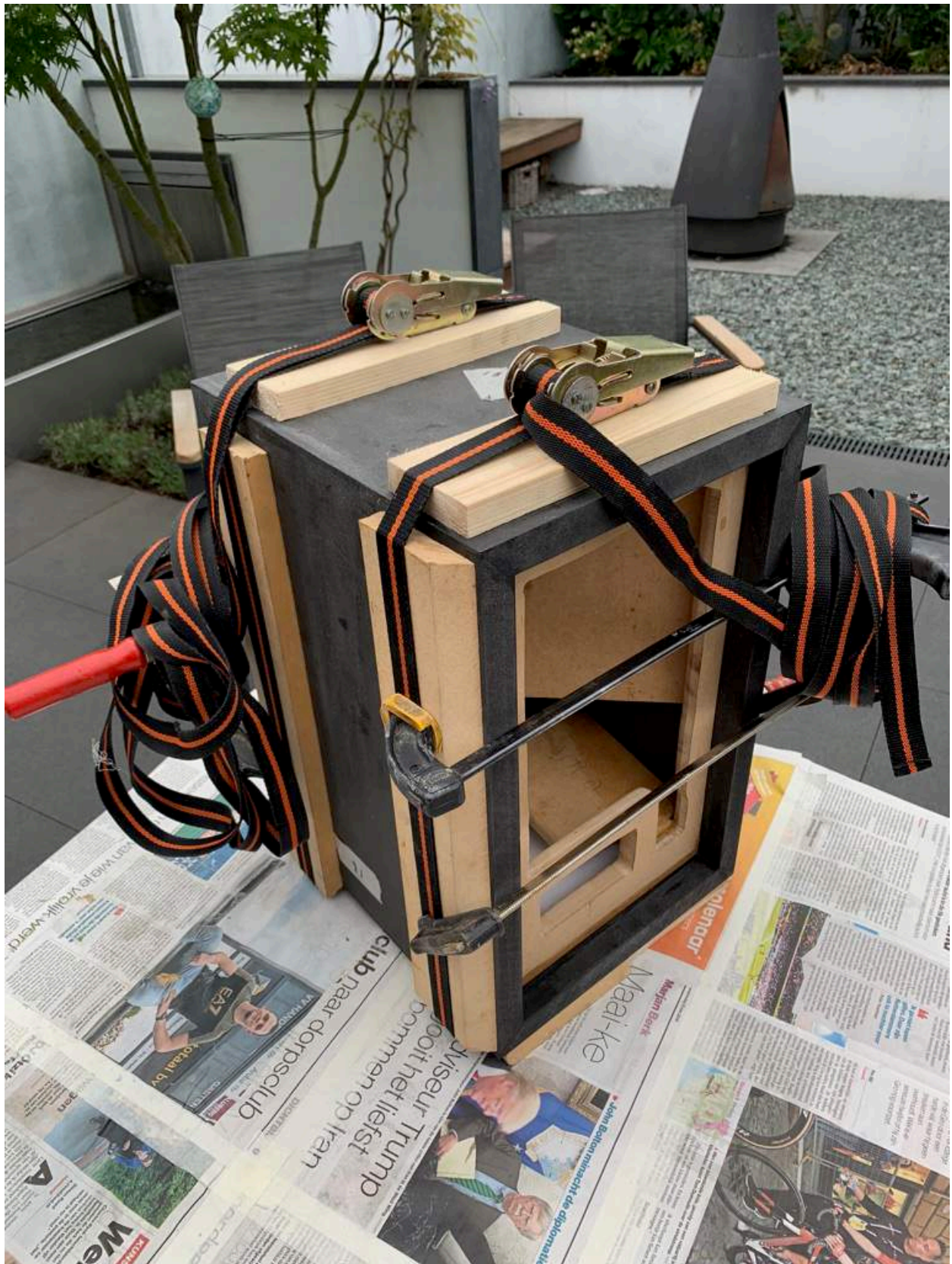
Figuur 24 Het in elkaar lijmen van de box met spanbanden en lijklemmen.
